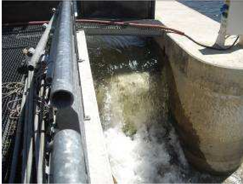
Figure 1 : Exemple de déversoir rectangulaire dénoyé.
