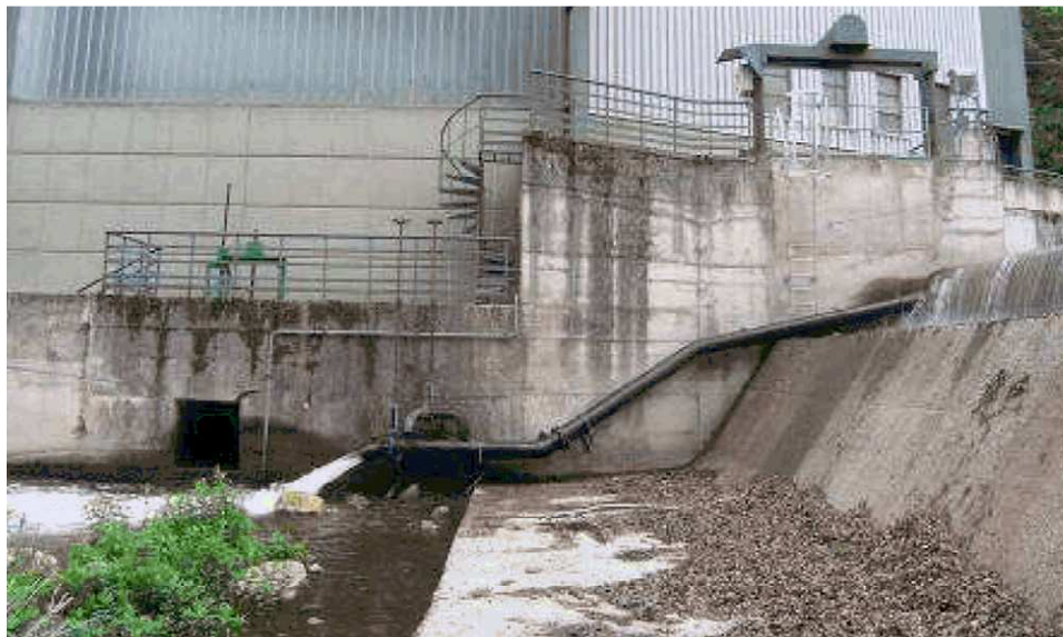
Figure 17 : Exemple de conduite en charge par syphon.
