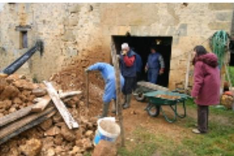
Puis il s'agissait de démonter les axes et bois des deux meules pour permettre la pose d'une poutre de soutènement et prévoir aussi la préparation de la rénovation des bois.
